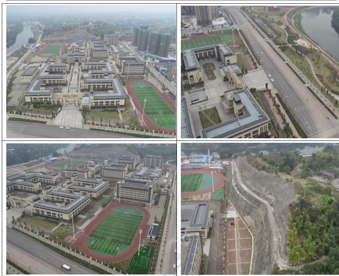
图 5-1 项目区现场运行情况
